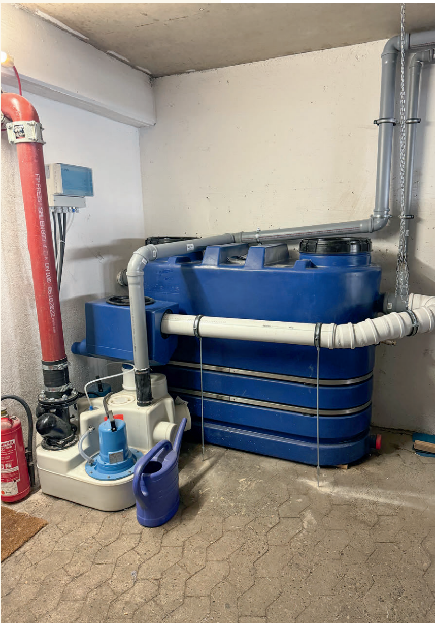
Der Fettabscheider wurde hier als Freiaufstellung eingebaut
